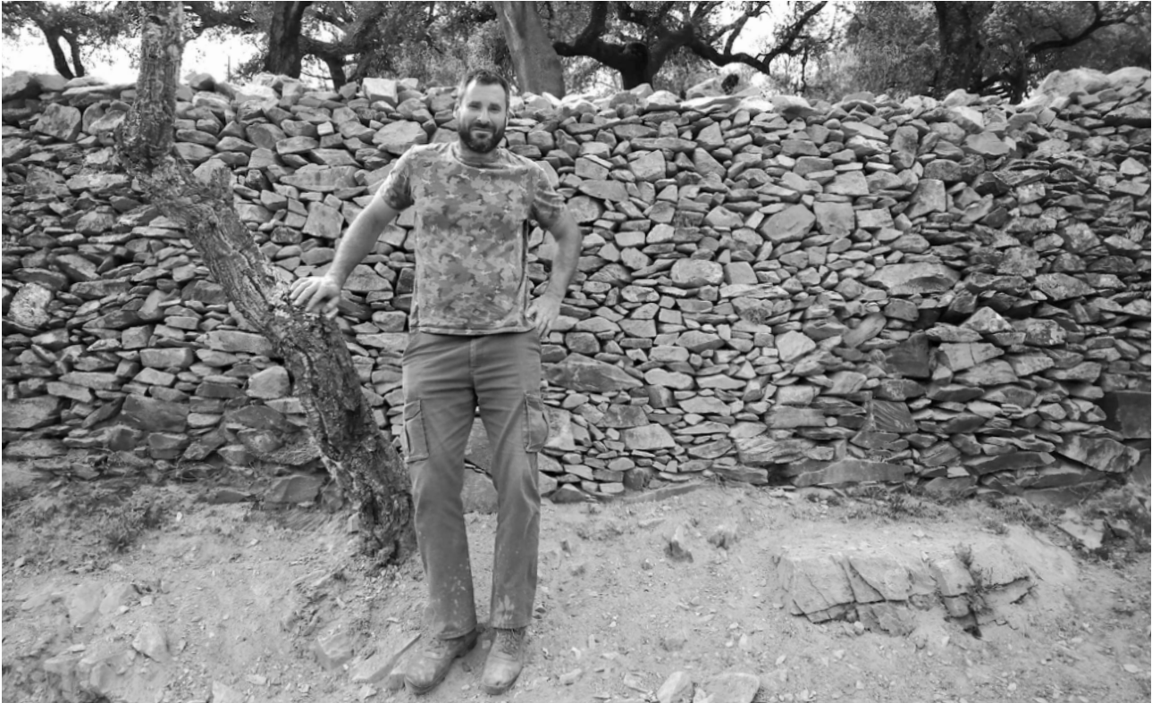
Juanmi junto al muro que ha restaurado. Foto: Ibán López
